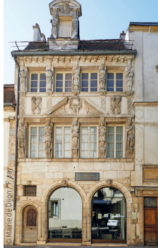
Maison des cariatides, 28 rue Chaudronnerie
