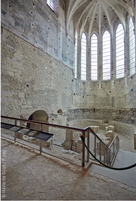
Fondation de l'église du 11 e siècle et élévation gothique du 15 e siècle
